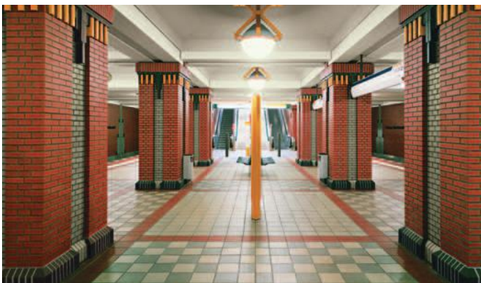
Objekt U-Bahnhof "Rathaus Reinickendorf", Berlin Architekt Dipl.-Ing. Rainer G. Rümmler Fassade Röben Klinker WESTERWALD, rot Röben Keramik-Klinker in orange, grau, schwarz
