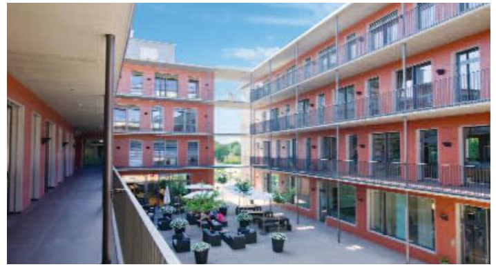
Der Innenhof präsentiert sich als mediterran gestal- tete Piazza. Großzügig dimensionierte Lauben- gänge erschließen die oberen Ebenen.
