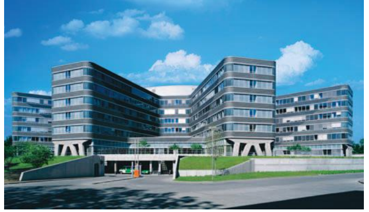
Objekt Polizeipräsidium Hamburg Architekt Bothe / Richter / Teherani, Hamburg Fassade Röben Keramik-Klinker FARO, schwarz-nuanciert. Röben Keramik-Klinker, weiß-grün glasiert, Architekten-Sortierung
