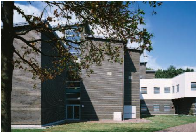
Mit den modernen, basaltbunten Röben Architekturklinkern CHELSEA lässt sich auch großflächiges Mauerwerk abwechslungsreich gestalten.
