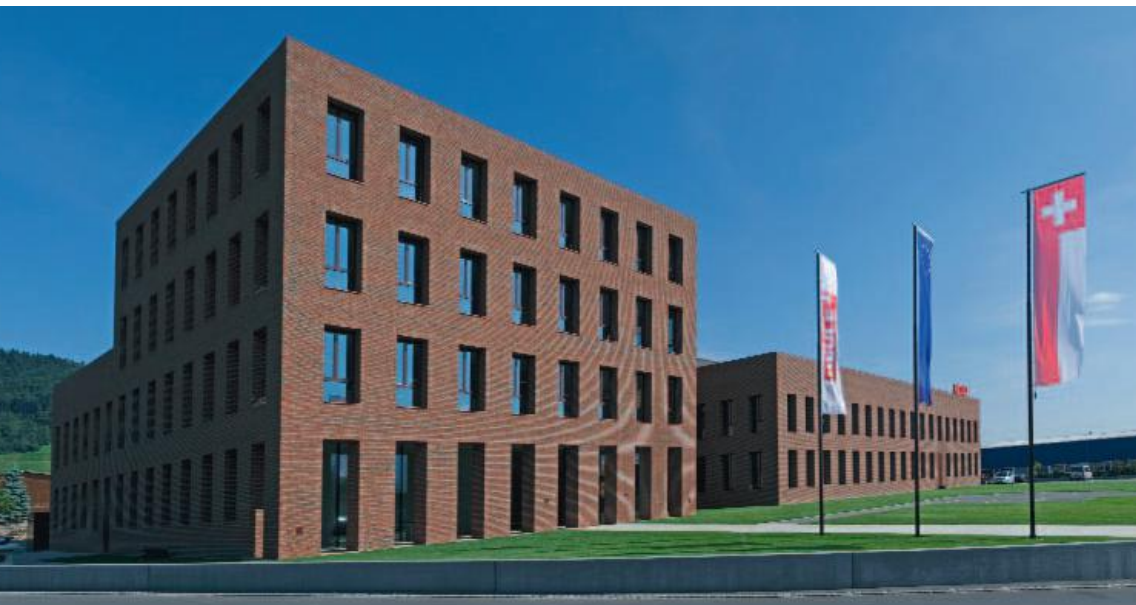
Der rustikale rote Röben Verblender betont die selbstbewußte Ausstrahlung der Architektur. Von Baubeginn an dabei: Der Röben PlanungsService. Seite 68
